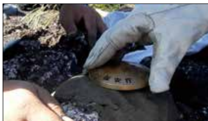
測量の基準点を設置
